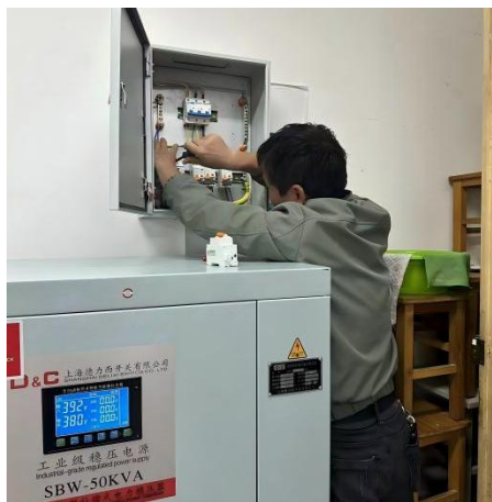
图 3 更换空开开关过程
